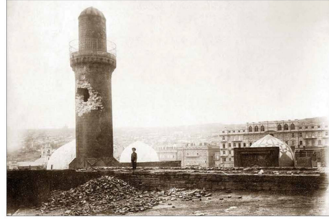
Минарет Шехериджети с восточной стороны, поврежденный артиллерийскими снарядами в городе Баку.
